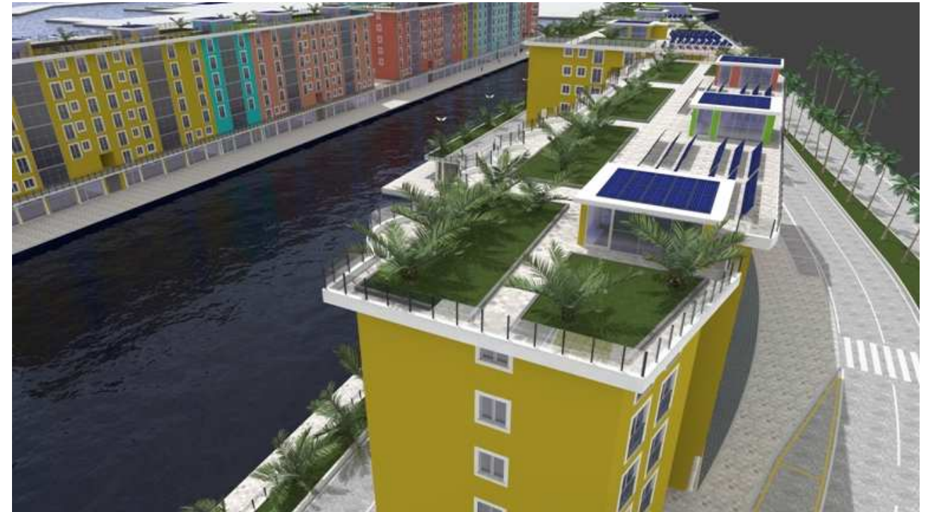
FIG. 4 – PERTICOLARE DI VERDE DI COPERTURA E PANNELLI FOTOVOLTAICI, PARAPETTO IN CRISTALLO
