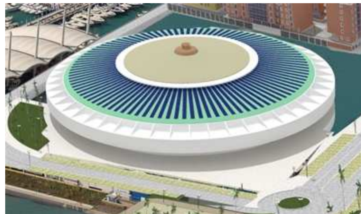
FIG. 2 – PARTE DI COPERTURA PALASPORT CON PANNELLI DI FOTOVOLTAICO FLESSIBILI MQ 11.350
