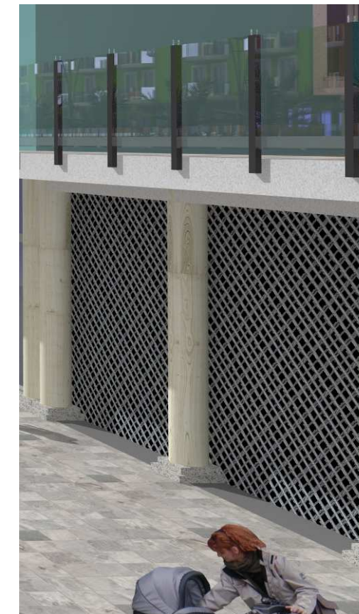
FIG. 12 - Particolare delle colonne in c.a. a vista, basamenti in Granito di Montorfano e parapetti in cristallo con montanti in acciaio
