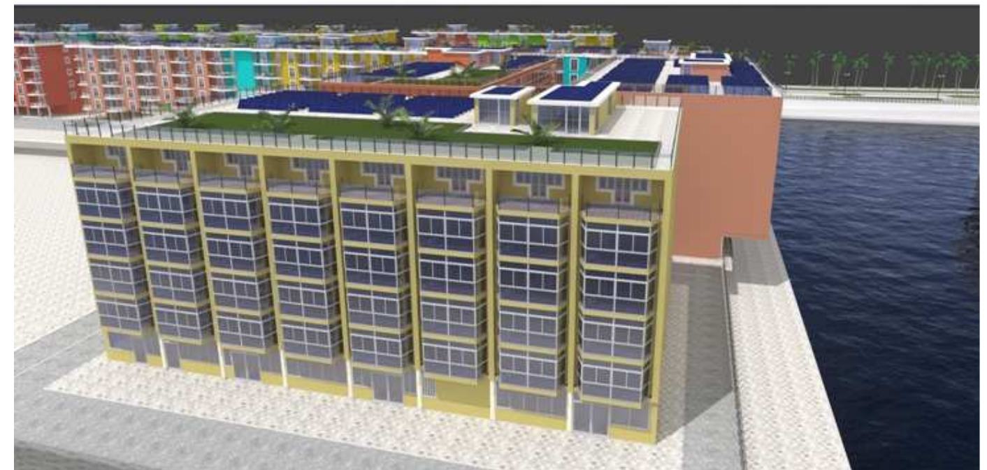
FIG. 5 – ALBERGO RISTORANTE, FACCIATA SUD OVEST CON VERDE DI COPERTURA E PANNELLI FOTOVOLTAICI
